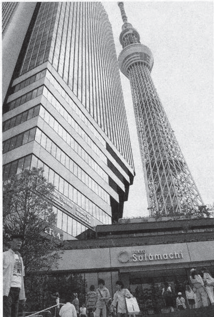
共立電機製作所が受電設備などを納入した東京スカイツリーイーストタワー（左側のビル）＝東京都墨田区
