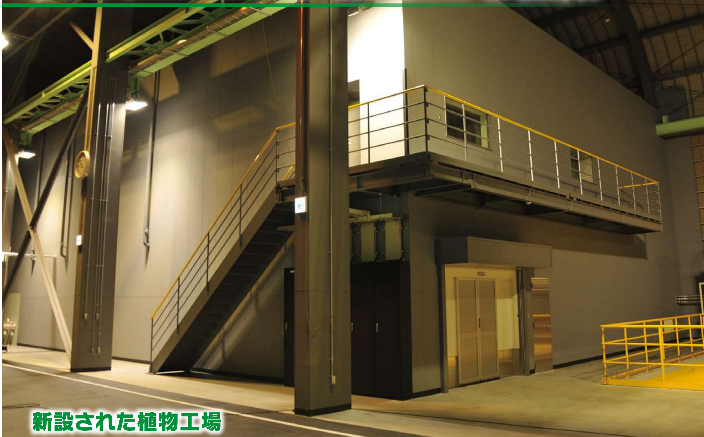
新設された植物工場
