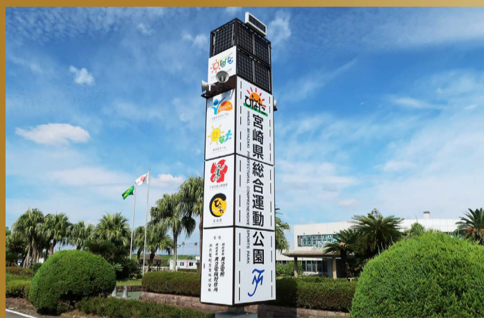
中央進入路に設置された照明灯
